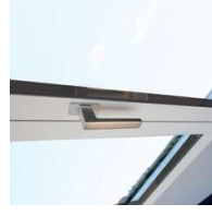
particolare maniglia e nodo centrale piano 115mm
